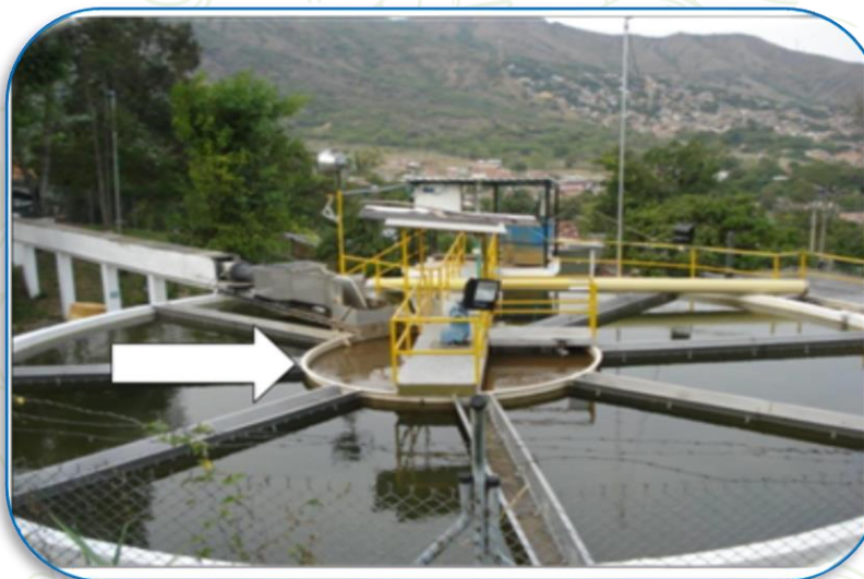
Ilustración 19 Cono decantador – Flocculación y Sedimentación
