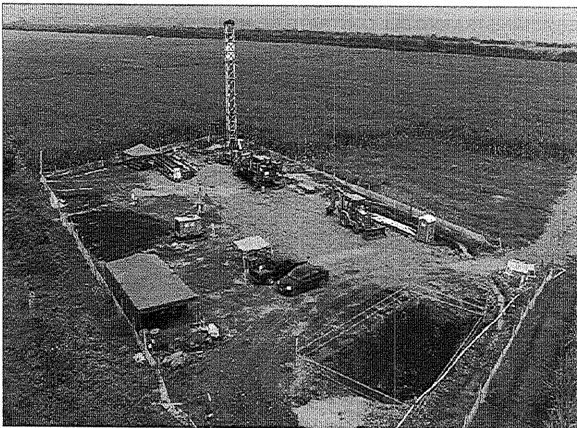
PREDIO: LOCALIZACION POZO HIGUERON
