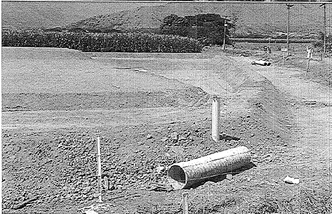
INSTACION TUBERIA DE IMPULSION- TERRAPLENES Y JARILLON PERIMETRAL.
