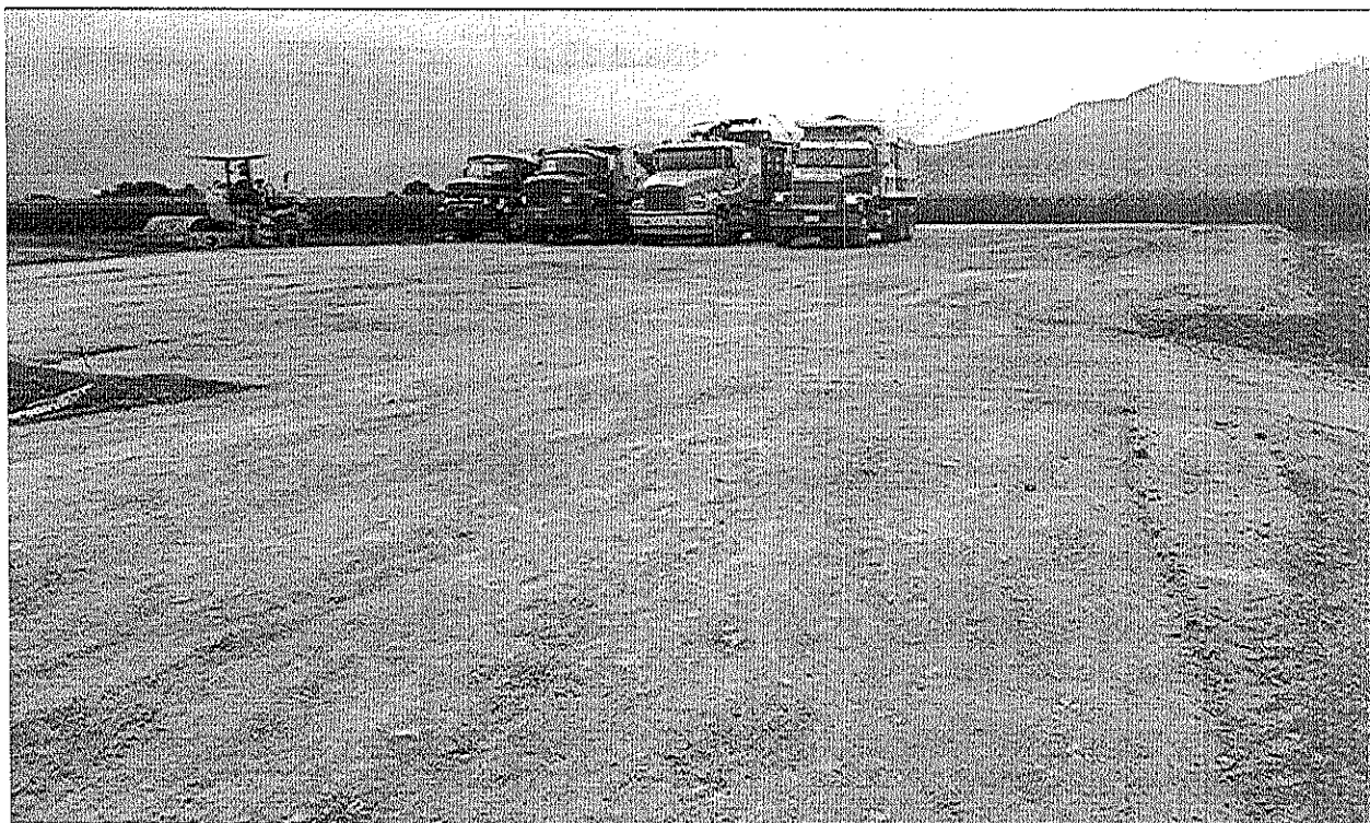
DESCRIPCION: ASPECTO TERRAPLEN COMPACTO
