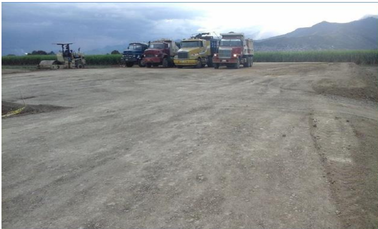
DESCRIPCION: ASPECTO TERRAPLEN COMPACTO
