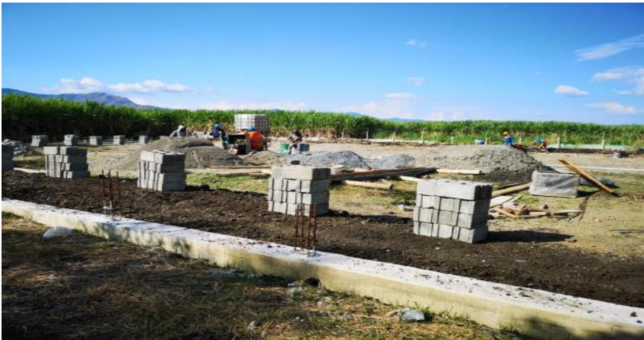
CERRAMIENTO POZO PROFUNDO DE HIGUERON
