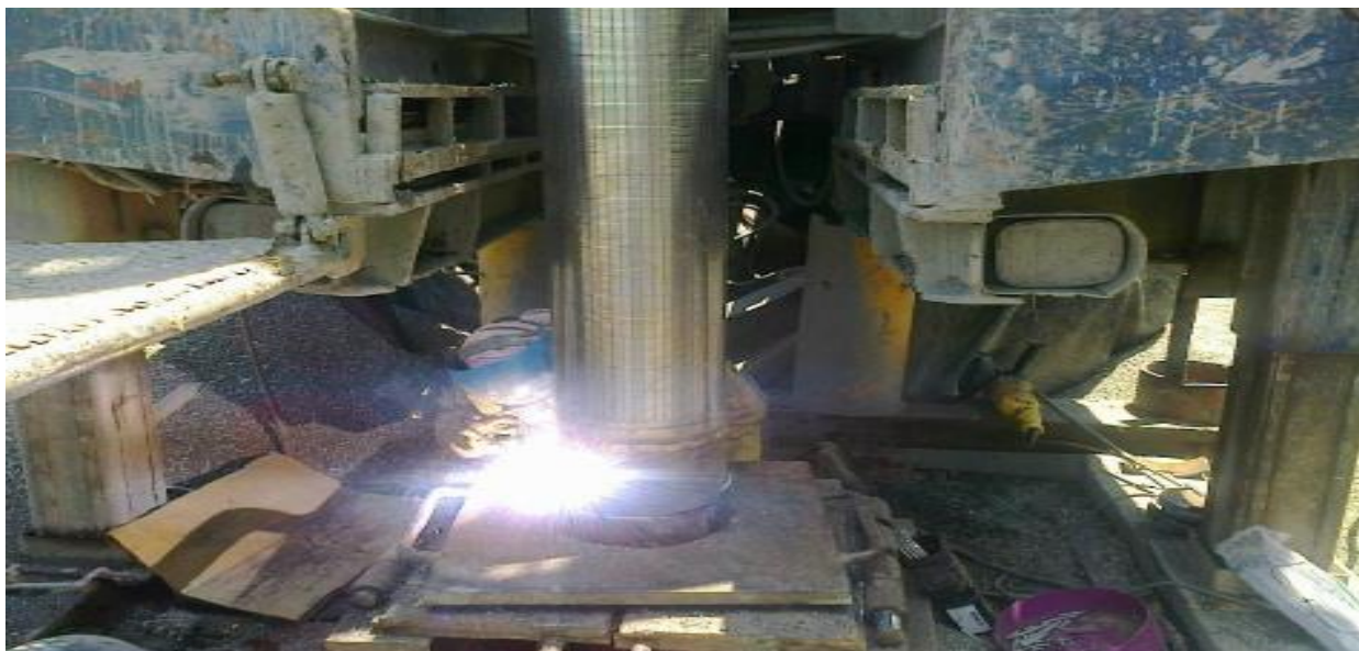
PRUEBA: REGISTRO GEOELECTRICO – SOLDADURA DE FILTROS INSTALACION POZO
