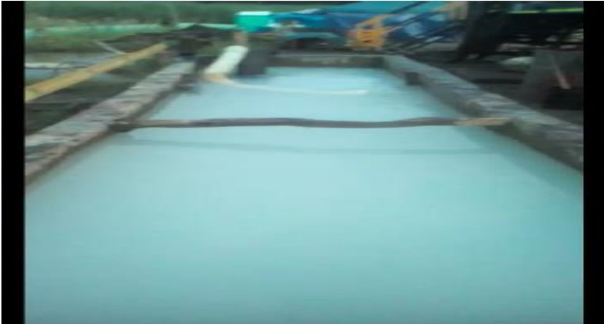
LAVADO DEL POZO – DESINFECCION DEL POZO
