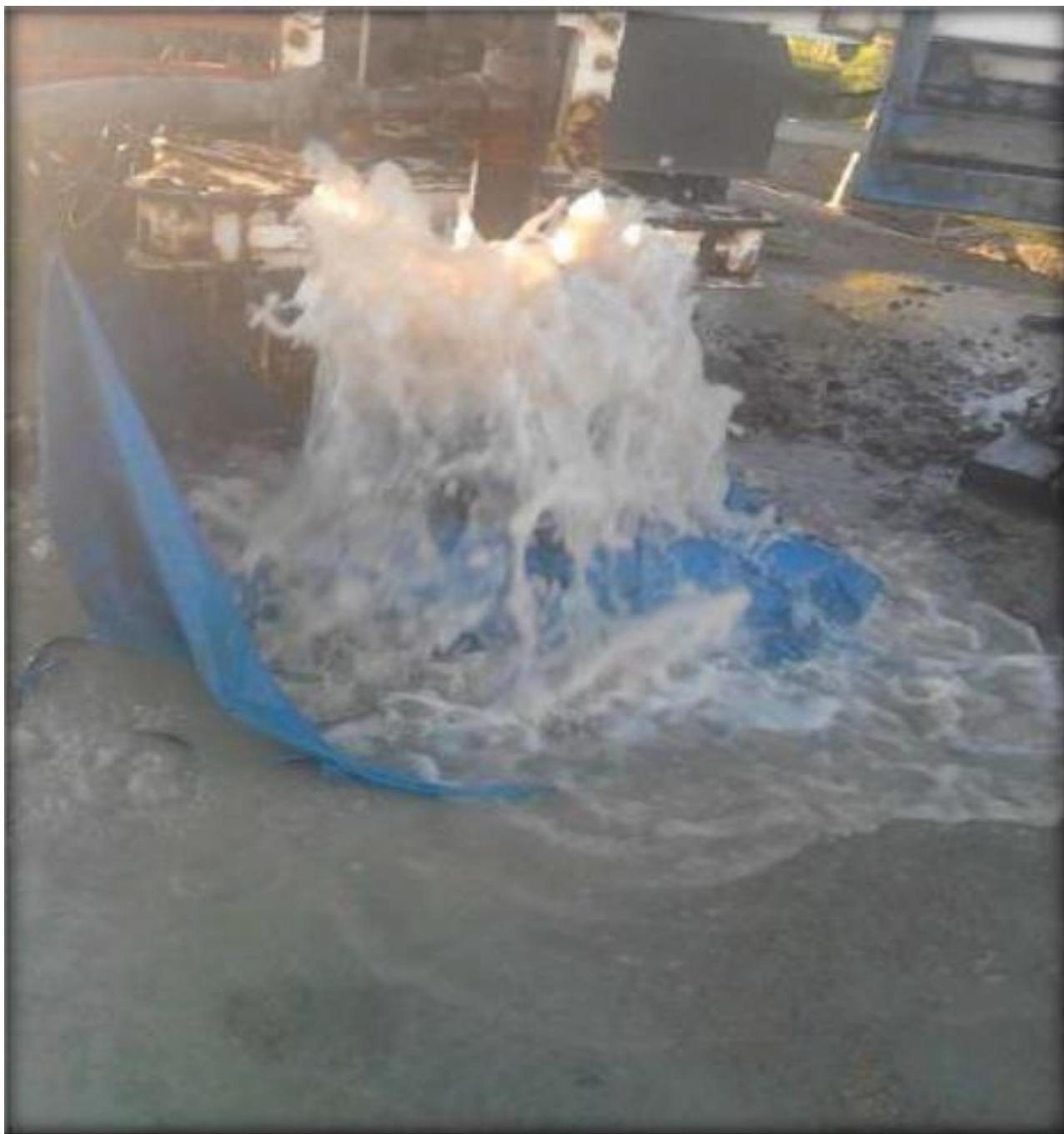
LAVADO DEL POZO
