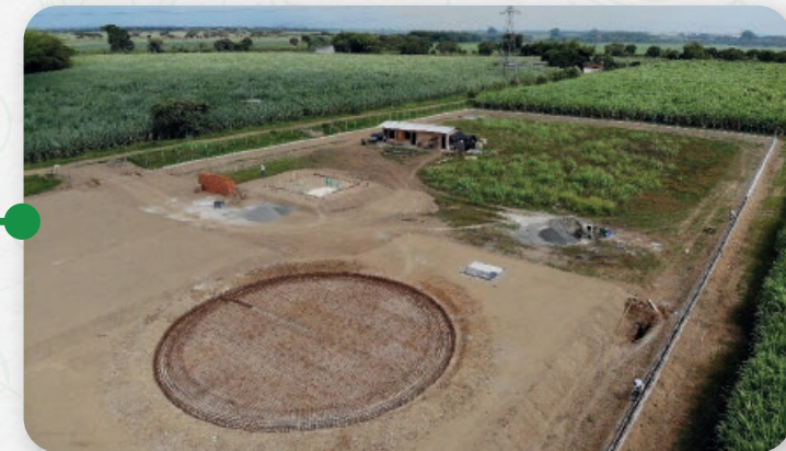
Construcción PTAP Platanares
