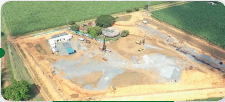
Construcción PTAR Urbana
