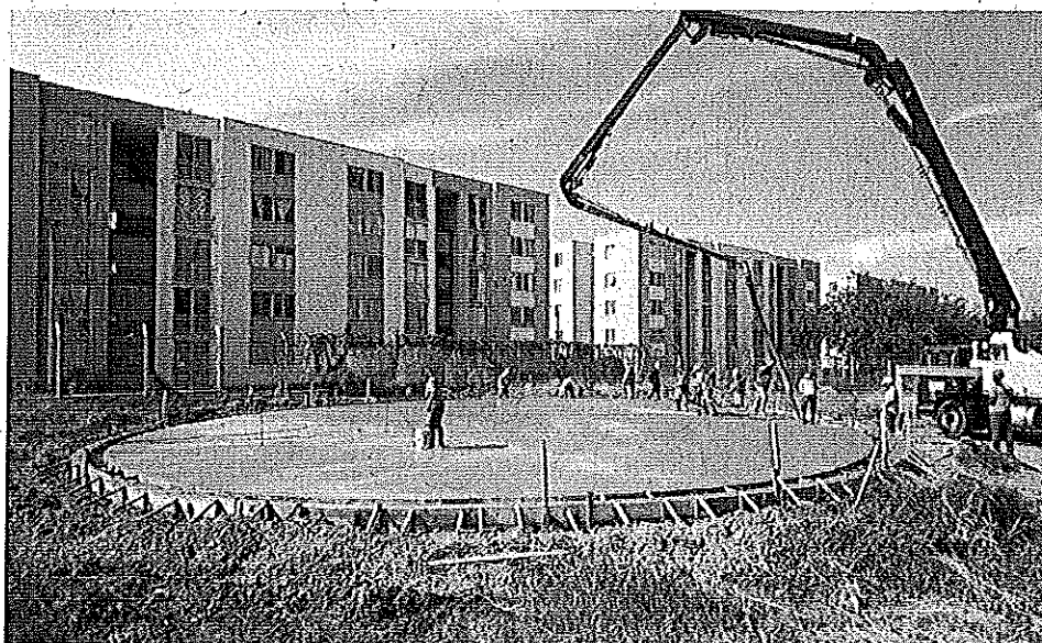
LOSA TANQUE ALMACENAMIENTO AGUA POTABLE
