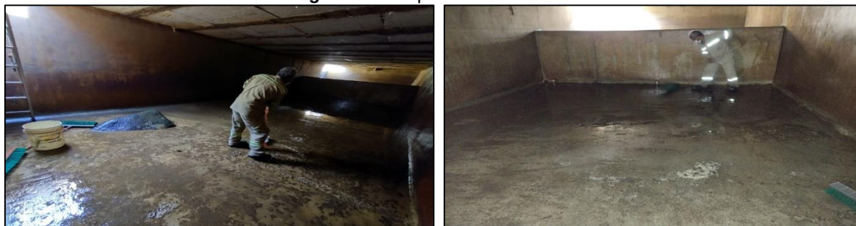
Figura 15. Limpieza desarenador.
