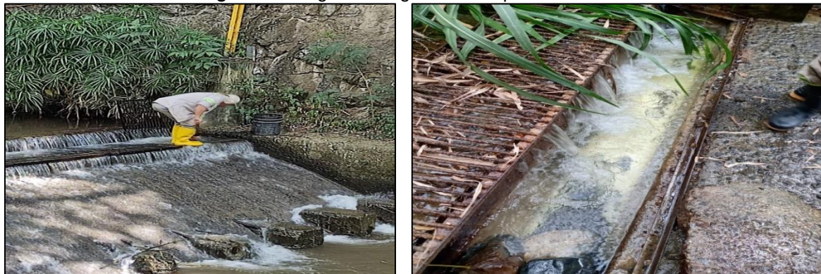
Figura 13. Registro fotográfico - Limpieza bocatomas.
