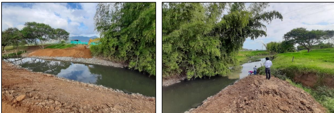
Figura 10. Registro Fotográfico – Obra ocupación de cauce sobre el río Yumbo.
