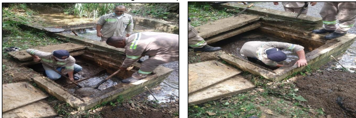
Figura 14. Limpieza desarenador.
