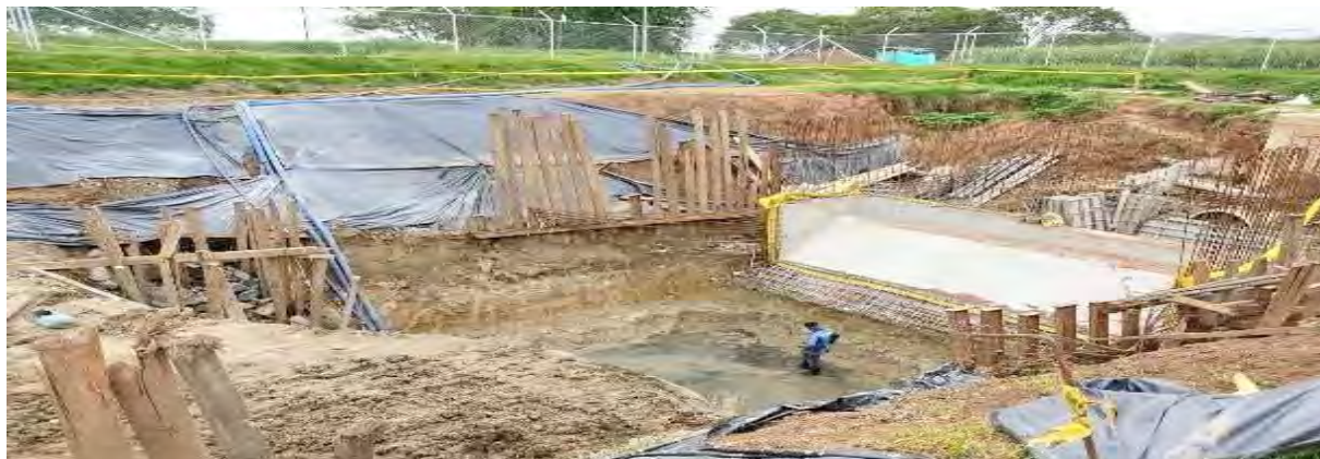
Avance construcción de Edificios eléctrico, laboratorio y administrativo - PTAR zona norte
