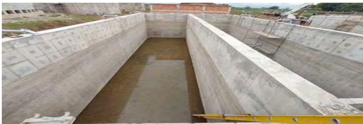
Avance construcción de Filtro Percolador - PTAR zona norte
