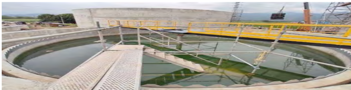
Avance construcción de Sedimentador secundario - PTAR zona norte
