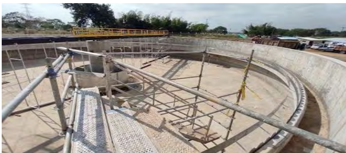
Avance construcción de Filtro Percolador - PTAR zona norte
