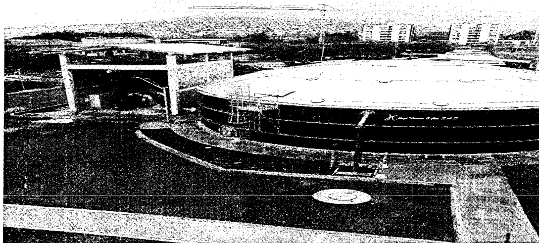
TANQUE DE ALMACENAMIENTO Y ESTACION DE BOMBEO
