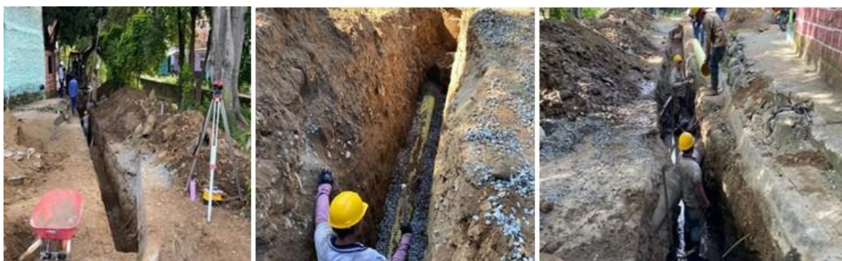
Foto 1. Reposición del colector sanitario auxiliar margen derecha del rio Yumbo entre calle 12 y calle 15.
