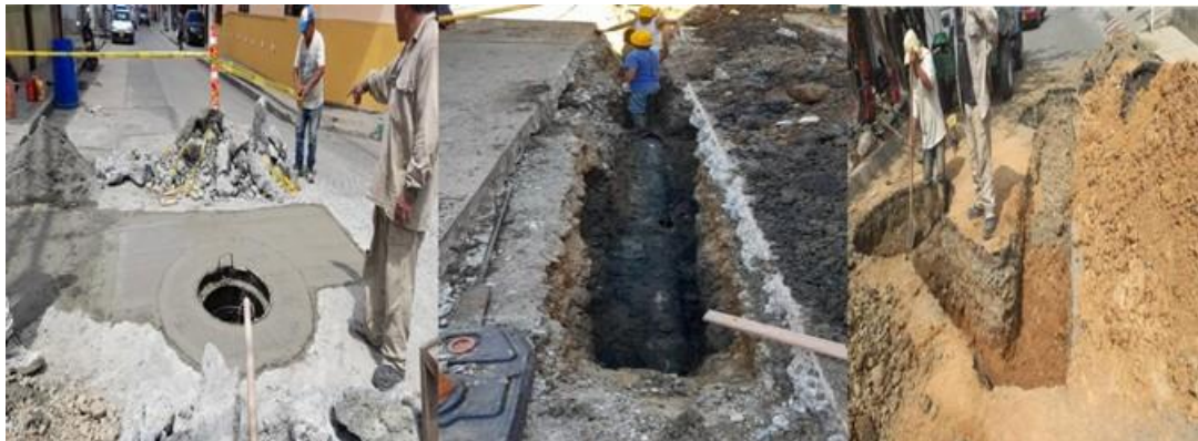
Foto 4. Acometidas de Alcantarillado
