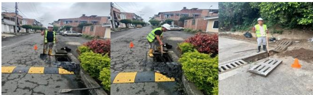
Foto 5. Limpieza de sumideros
