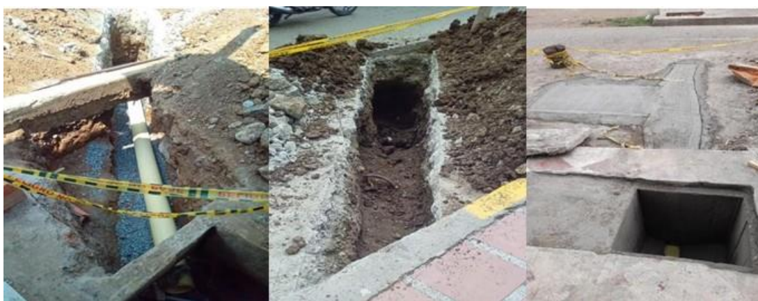
Foto 4. Acometidas de Alcantarillado
