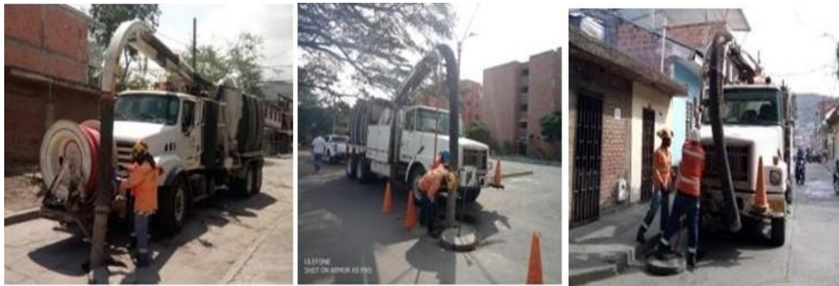
Foto 3. Reparaciones y mantenimiento de alcantarillado.
