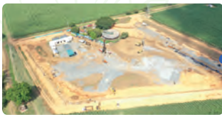
Construcción PTAR Urbana
